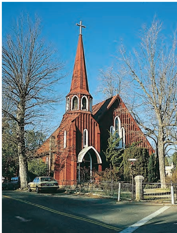
Episkopalkirche in Sonora
