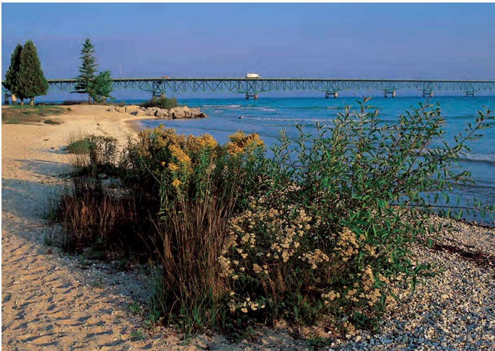
Mackinac Bridge bei Mackinac City, Michigan
